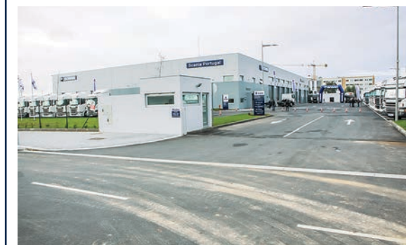
As instalações ficam em Moreira da Maia.
